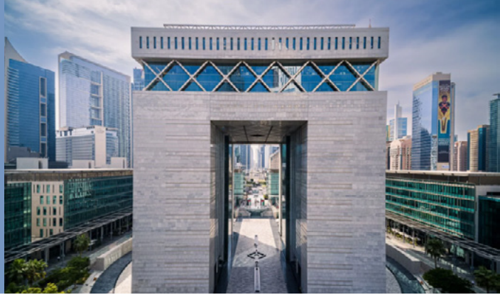
Emiratos Árabes Unidos. DIFC Tunnel
